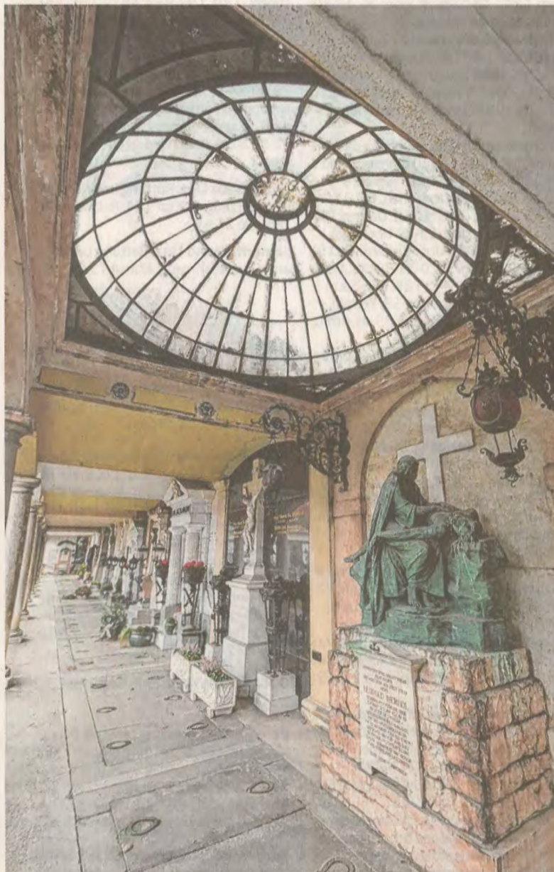
Bei der Werndlgruft muss eine Schmutzschicht entfernt werden.
